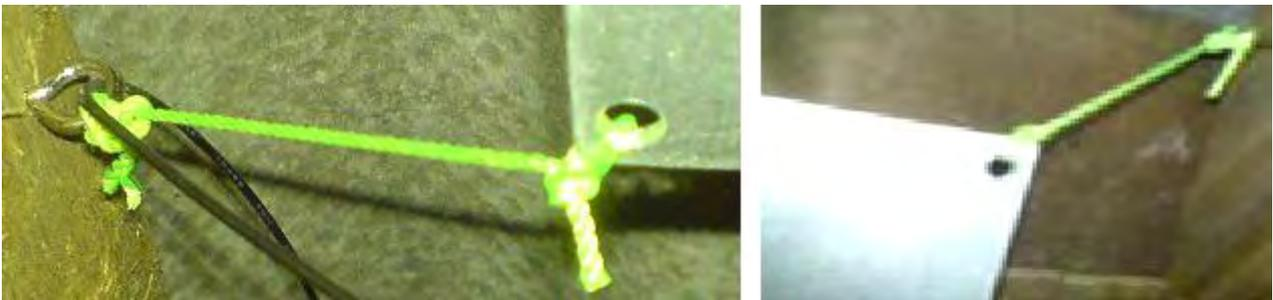
Die Platte befindet sich zwischen 3 und 3,5 Metern über dem Boden. Die Befestigung an der Platte erfolgt über ein 8-swg-Hochleistungskabel:
