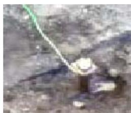
El cable utilizado para conectar con la varilla de puesta a tierra es muy importante y no debe tener menos de 8 hilos de cobre, es decir, 4 mm de diámetro y 13 mm cuadrados. área de sección transversal. Con este dispositivo de energía libre, este es un detalle importante al igual que los diodos utilizados, que son germanio 1N34 o 1N34a, que son particularmente adecuados para esta aplicación debido a su muy baja caída de voltaje. Para los condensadores de 200 nF, se recomiendan los tipos de
